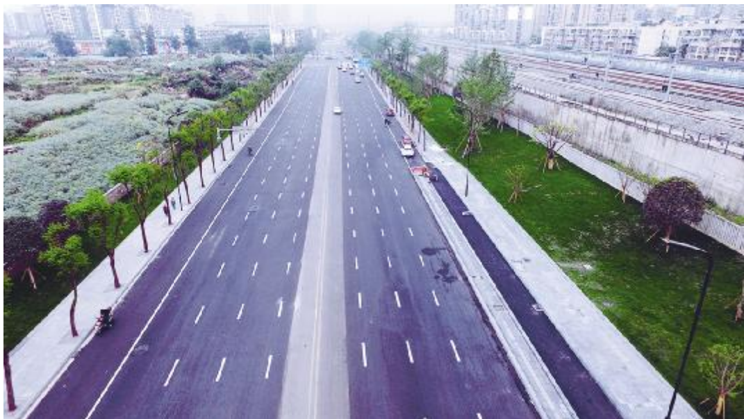
完工后的成都中环路地铁7号线道路恢复提升工程
